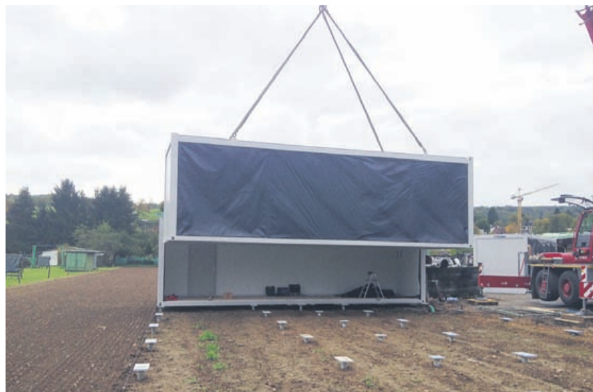
Schwebende Containerelemente im Stettenfeld – die Hallenelemente werden auf die Schraubfundamente montiert.
